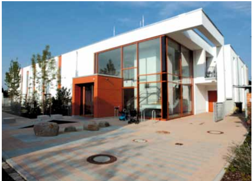
Der Gebäudeeingang mit Vorplatz: Im Hintergrund die Bruchsteine, Rampe und Steinquader
